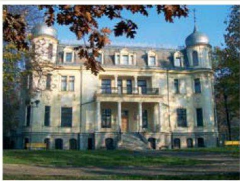
Sosnowiec - pałac Schoena, fot. R. Piwkowski
