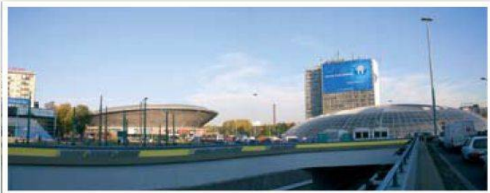
Katowice - Spodek, fot. E. Kaniewski
